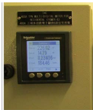
照片 A.12 400A 电路计量装置
